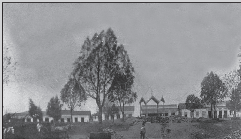
O Largo São João em obras: iniciativa do intendente Edmundo Trench, 1905
