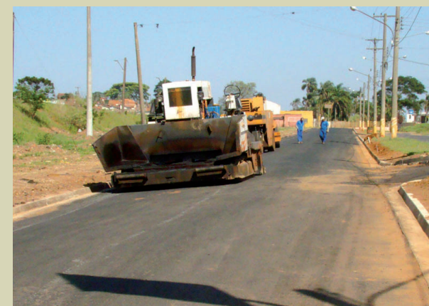
Obras prosseguem na Avenida Paranapanema
