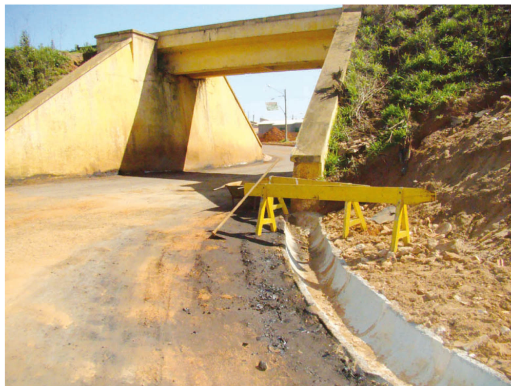
Construção de canaletas para escoamento de águas pluviais
