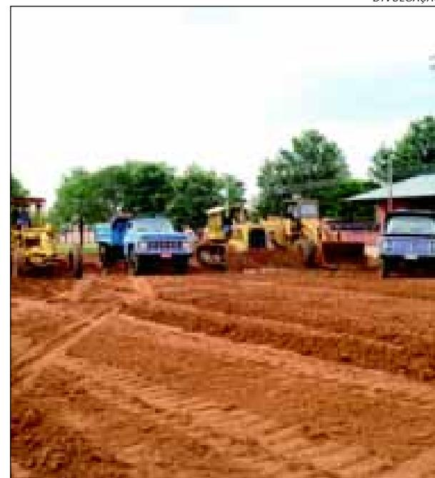
*Obras de terraplenagem (já concluídas) do local onde será construído a nova pista de laço totalmente coberta em estrutura metálica*
