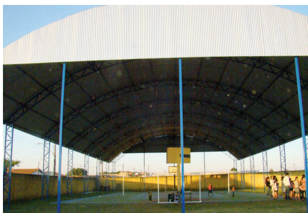
Cobertura da Quadra Esportiva da EMEB Carlos Papa
