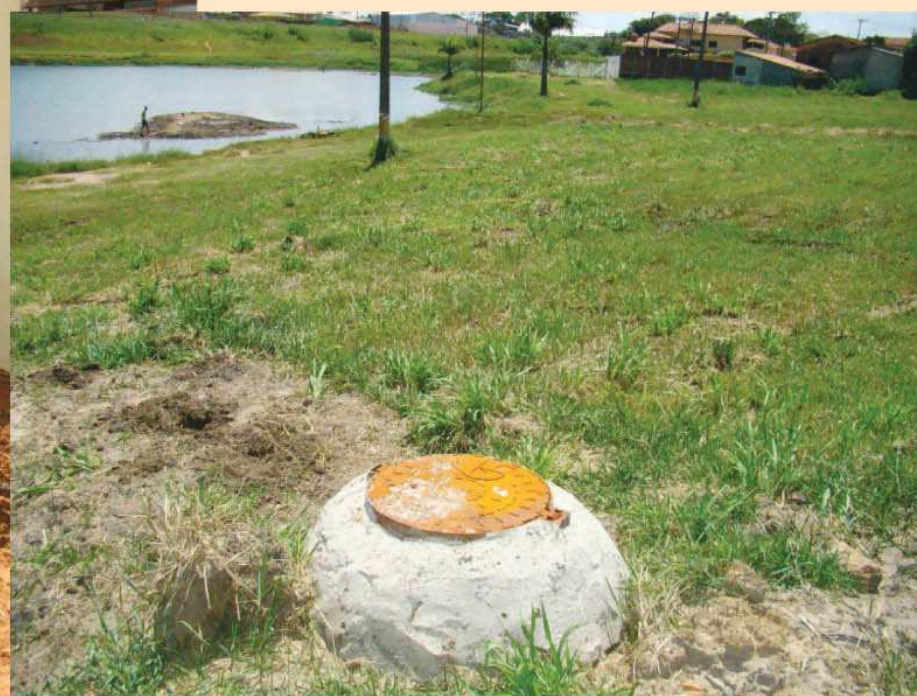
Instalação da rede de esgoto na Rua Alan Kardec
