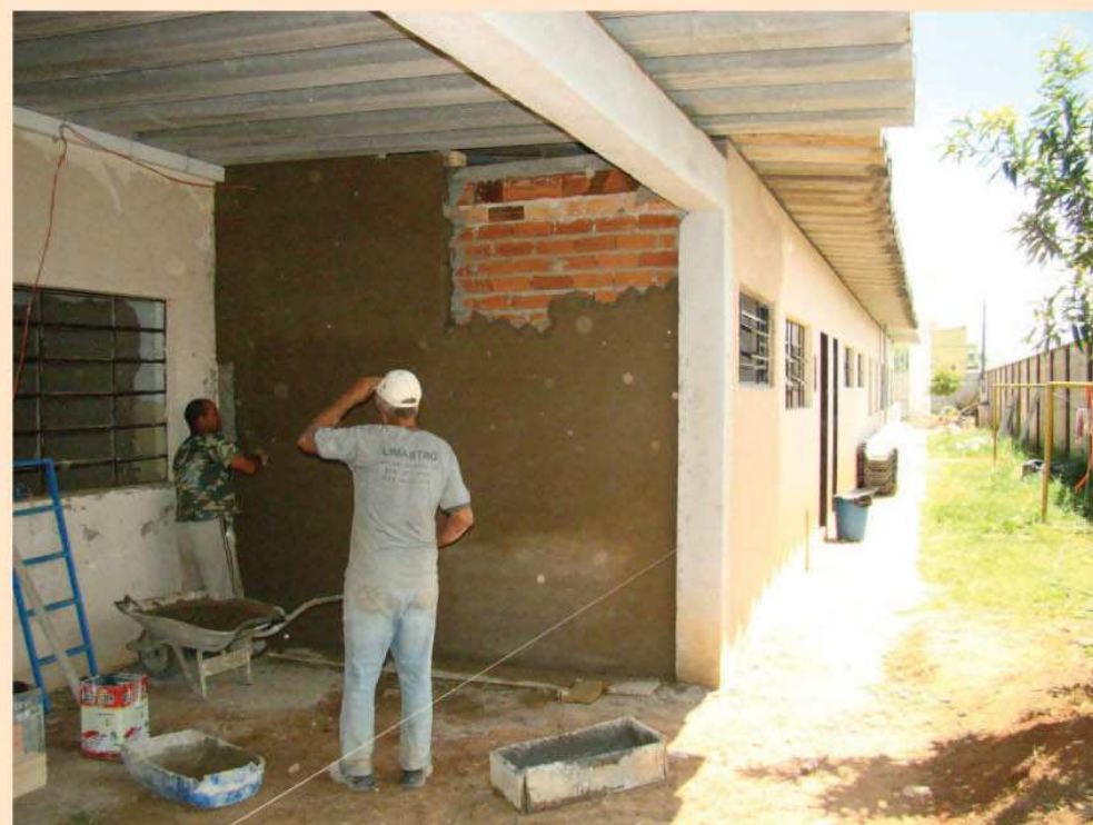
Ampliação e cobertura do pátio do CEI Carolina Puzziello
