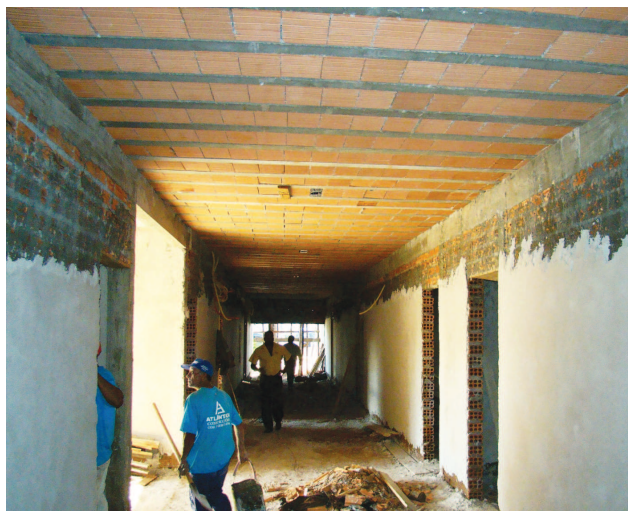
Obras de reconstrução da escola Licínia Guazelli
