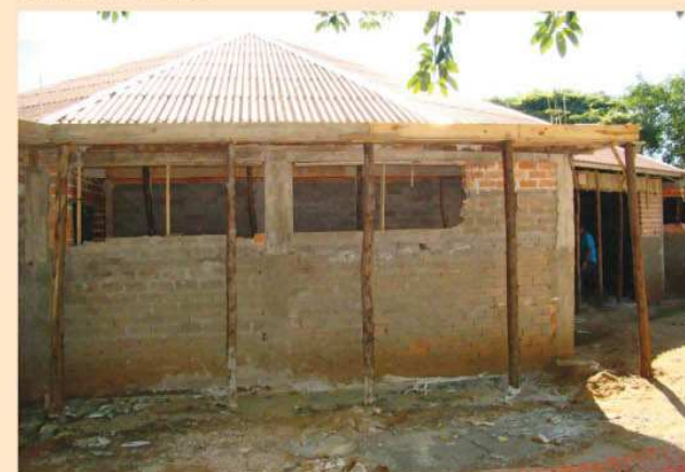
Construção do Restaurante Panorâmico do Camping
